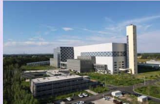
固安县生活垃圾焚烧 发电厂项目
